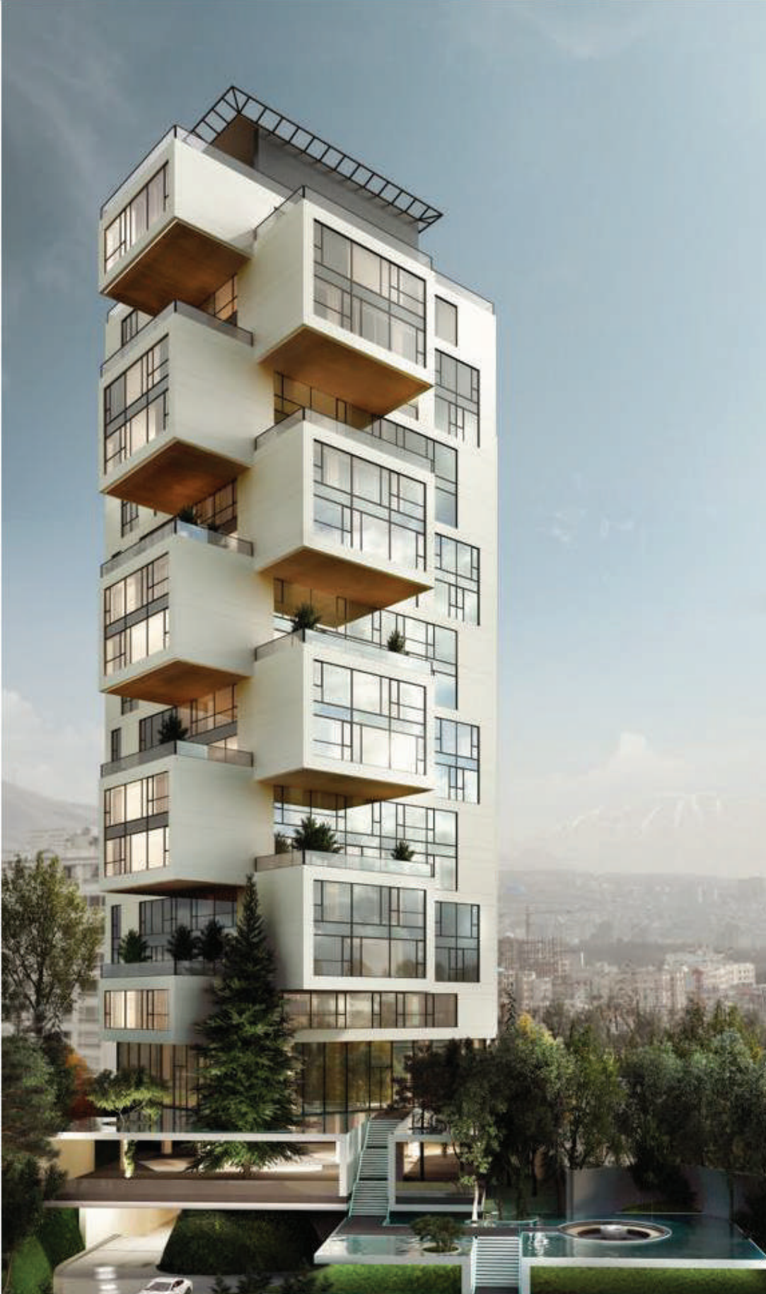
پروژه پمپ های فاضلابی حیات نیاوران
